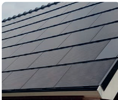
Zijkant over de zijgevel
