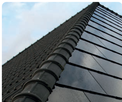
Zijkant onder hoekkepers
