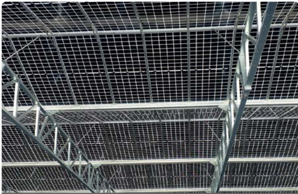
Ein solides Dach
