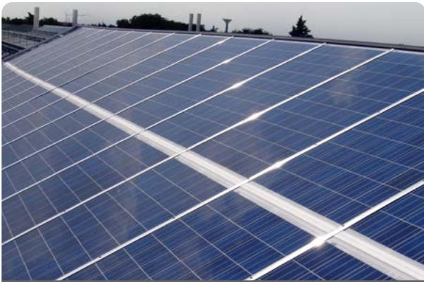
Utilisation of roof area
