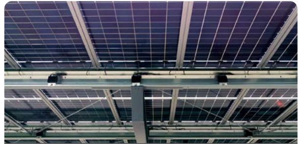
Montage sur pannes en acier
