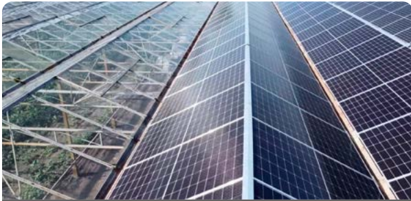
Overgang glas naar zonnepaneel
