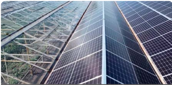
Overgang glas naar zonnepaneel
